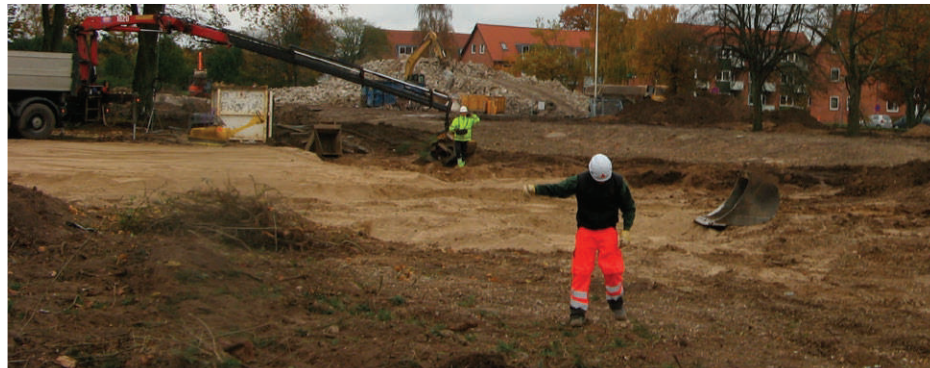
I skrivende stund er nedbrydningsfirmaet ved at have afsluttet sit arbejde. Første spadestik til Fremtidens Plejehjem forventes taget den 8. november (efter redaktionens slutning). Det nye plejecenter forventes klar til indflytning inden udgangen af 2017.
