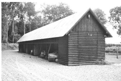
Eksempel på garagebygning opført med facade af træbeklædning. Garage ved herregården Støvringgård. Støvringgårdvej 73, Randers.
