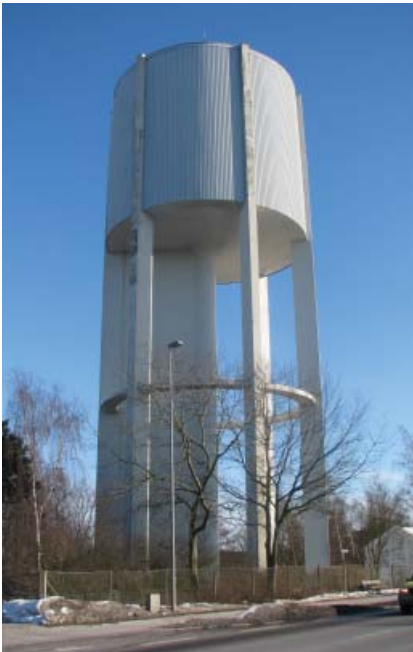
Det oprindelige vandtårn fra 1950 set fra Hadsundvej. Den øverste cylinder, som er selve vandbeholderen, bevares ikke.
